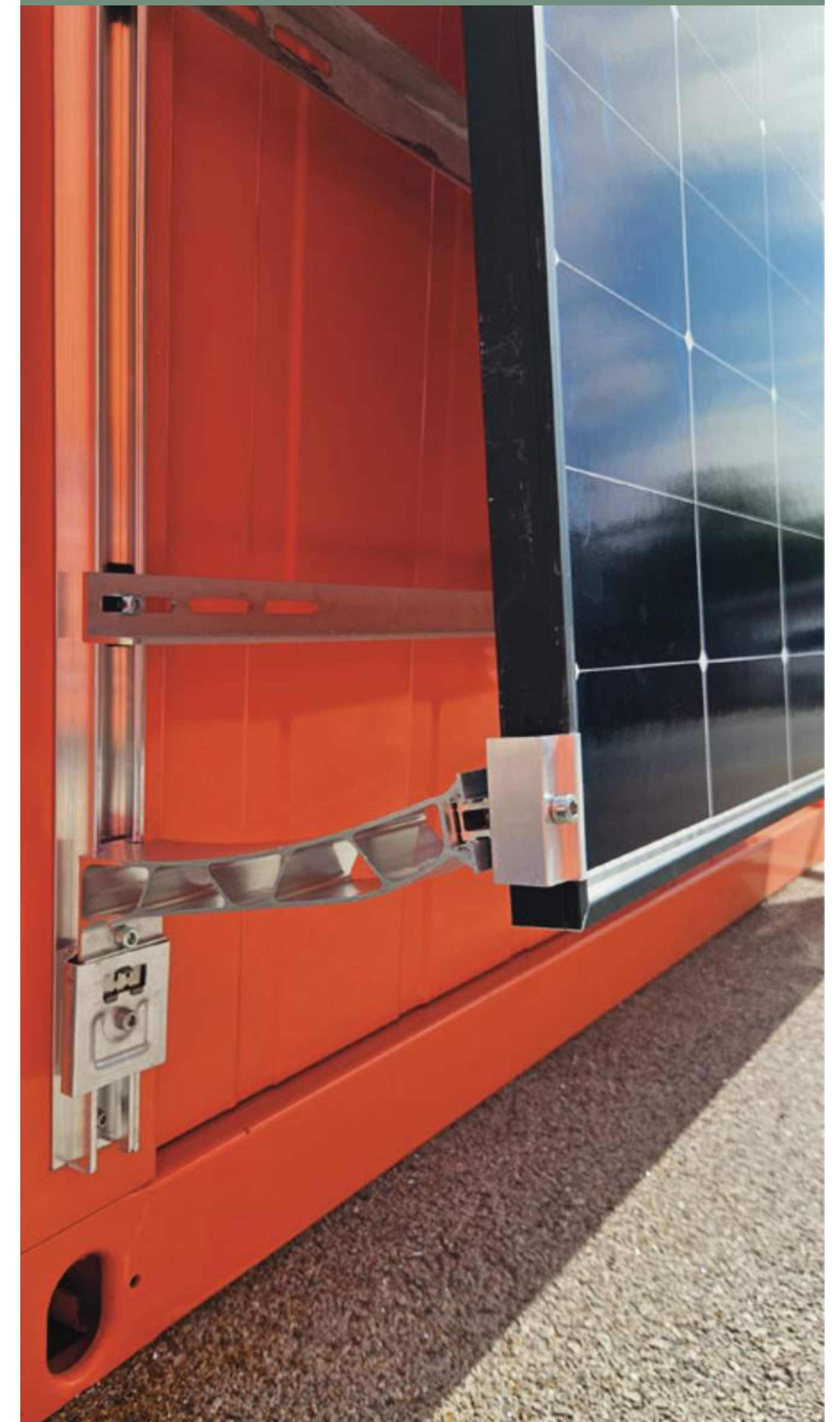
Montaje de paneles solares
