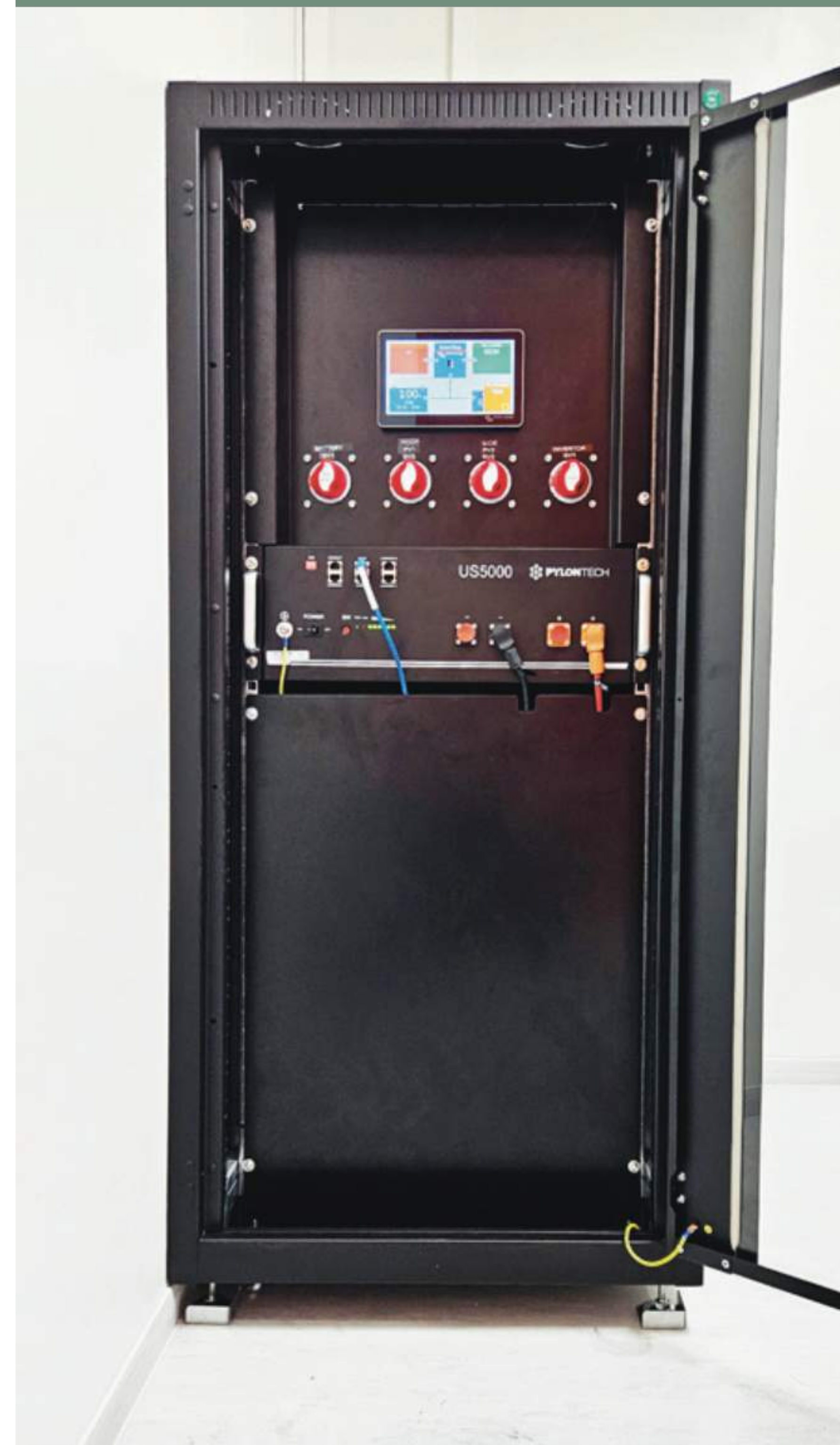
Panel de control independiente de la red
