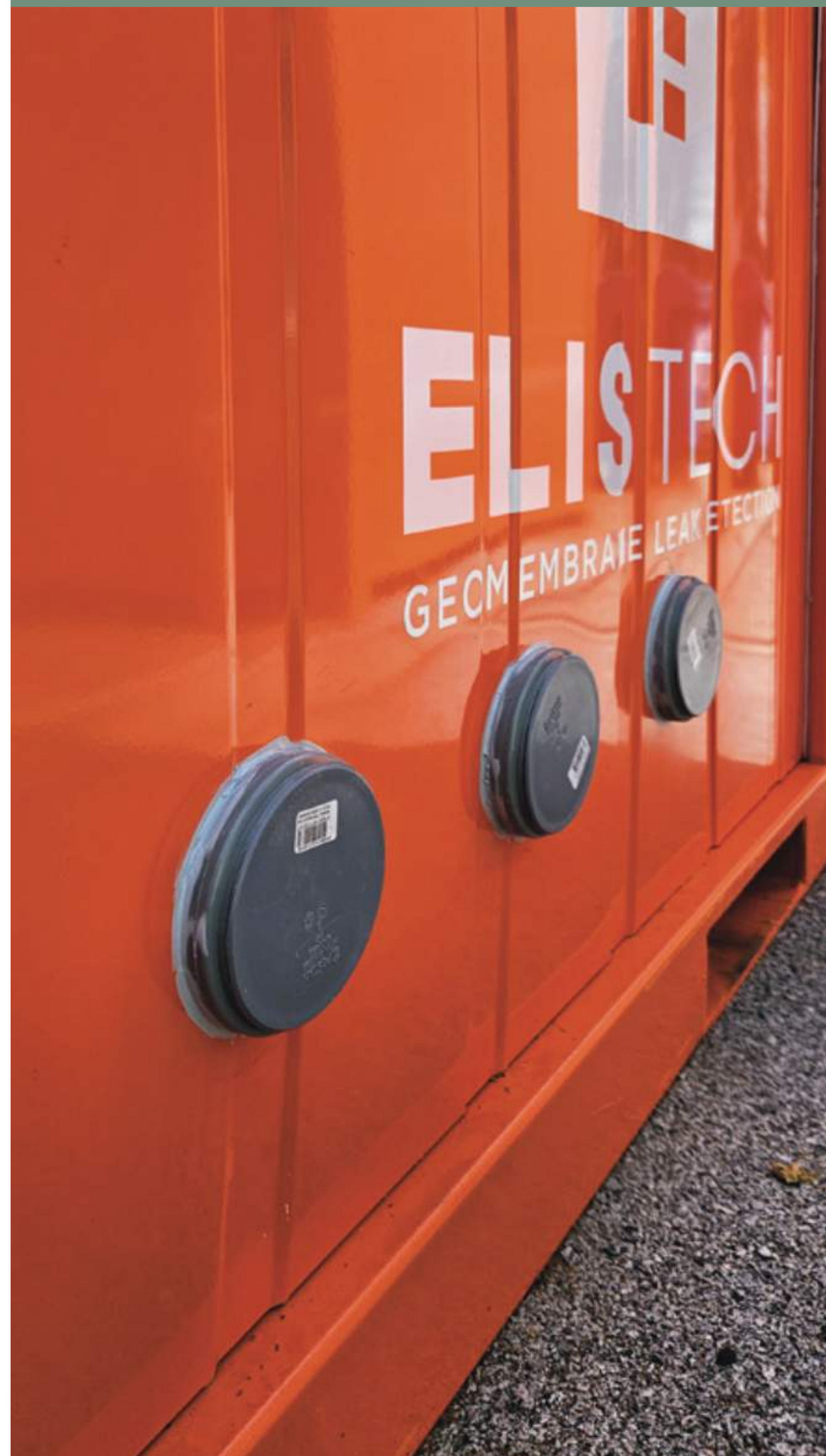
Penetraciones de cable
